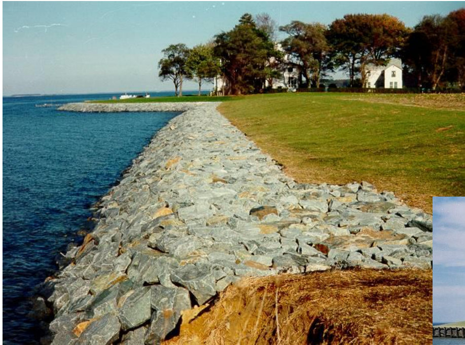
Rip-rap or Revetment
